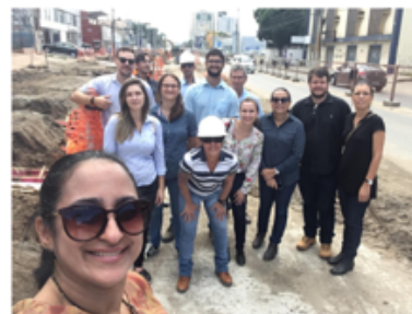
Visita às obras da Av. Leitão da Silva
